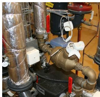
Bild 13. Varmvattenanvändningen mäts via separat flödesmätare.
