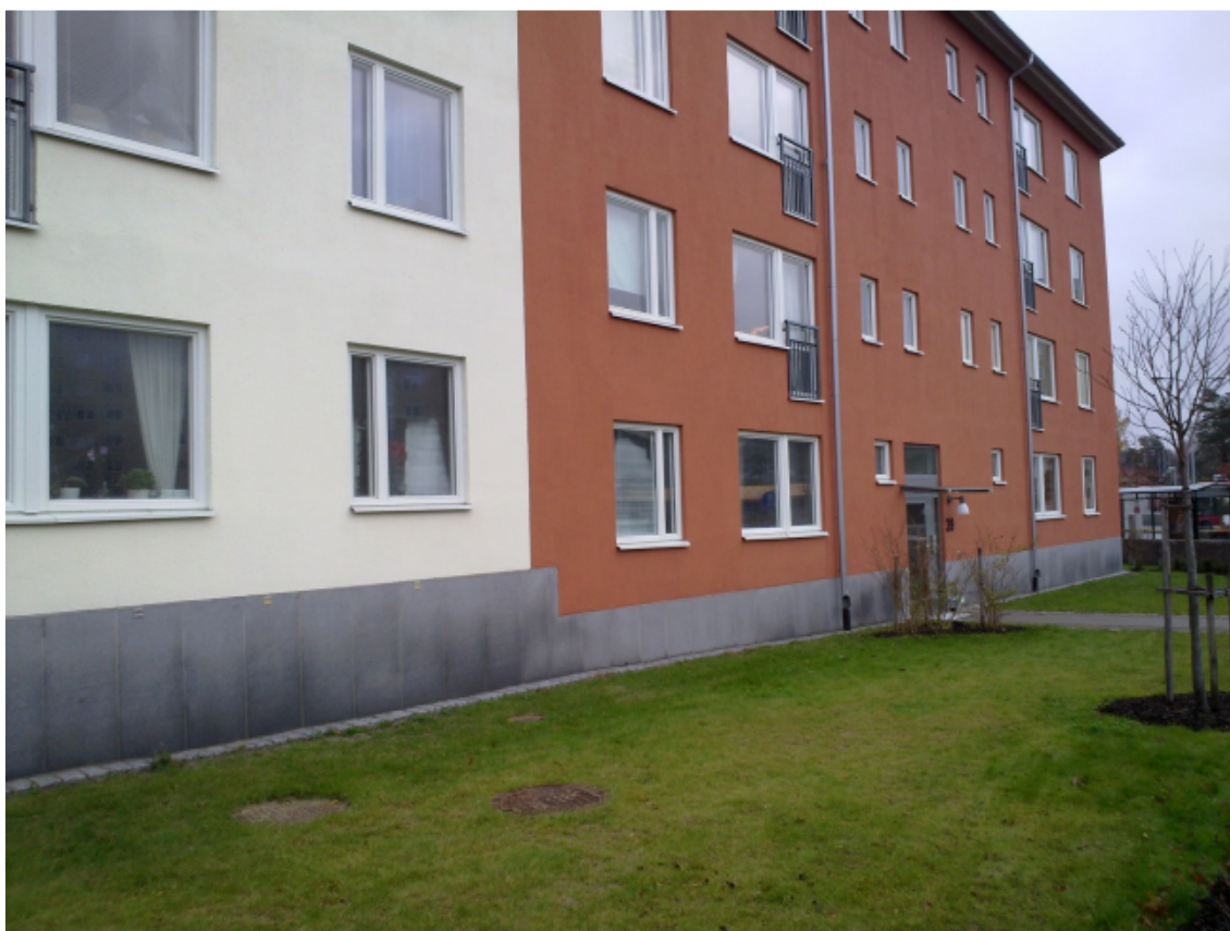
Tävlingshusets fasad mot Kommunalvägen i söder.
