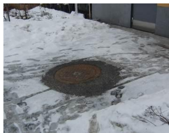
Bild 15. Värmeförlusterna är större vid markbrunnar till kulvertsystemets fördelningspunkter.
