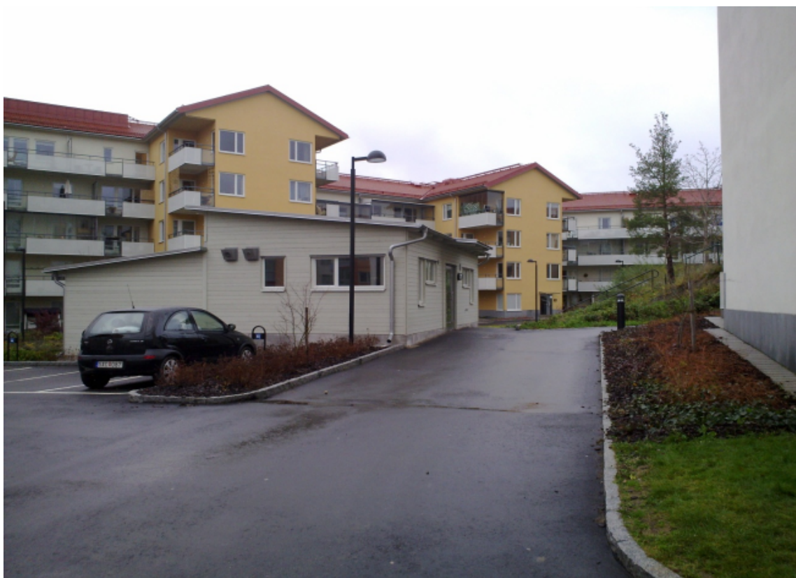
Tvättstuge- och förrådsbyggnaden sedd från motsatt håll.
