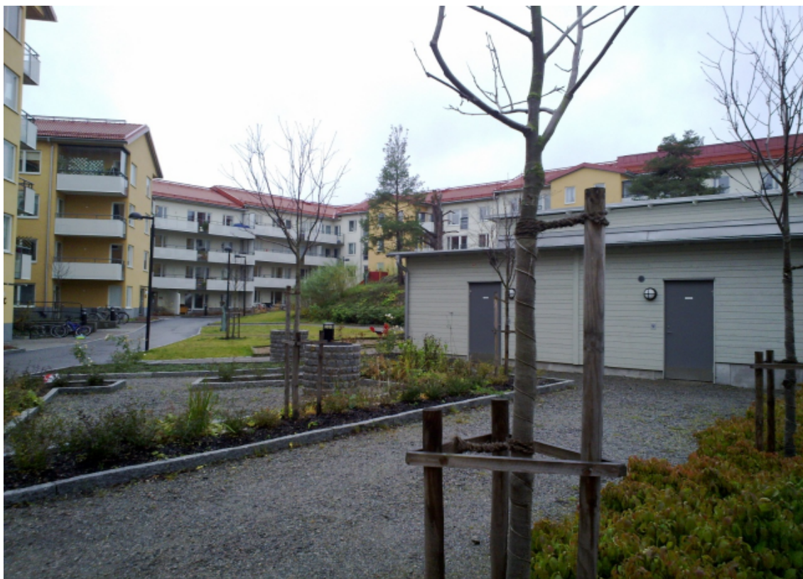
Tävlingshusets innergård, den kombinerade tvättstuge- och förrådsbyggnaden i mitten ingick ej i energiberäkningen.
