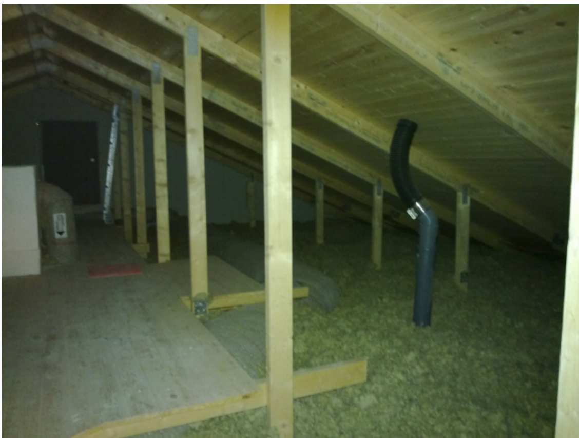
Vindsisolering med lösull och nätsolerade kanaler.
