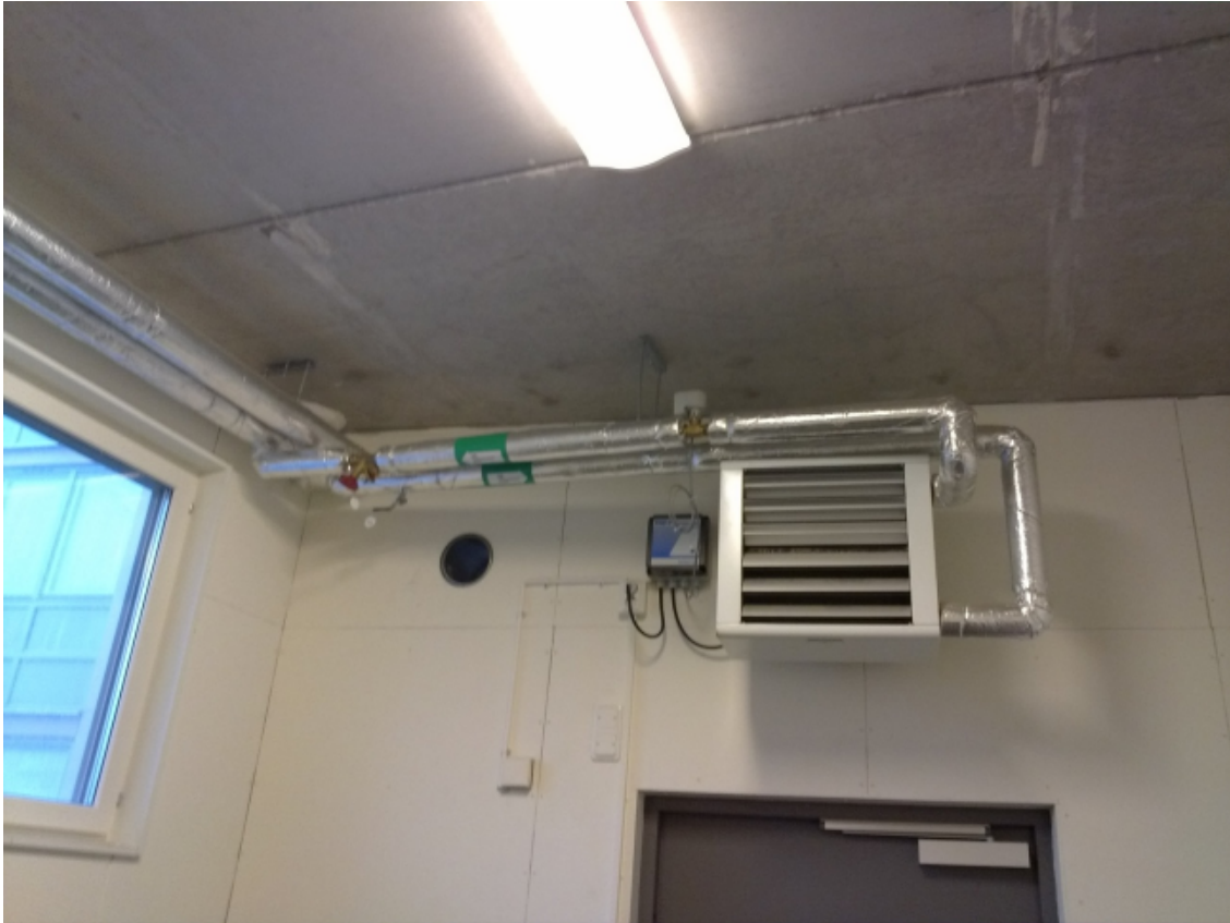
Värmeförstärkning i soprum pga oisolerat bjälklag.
