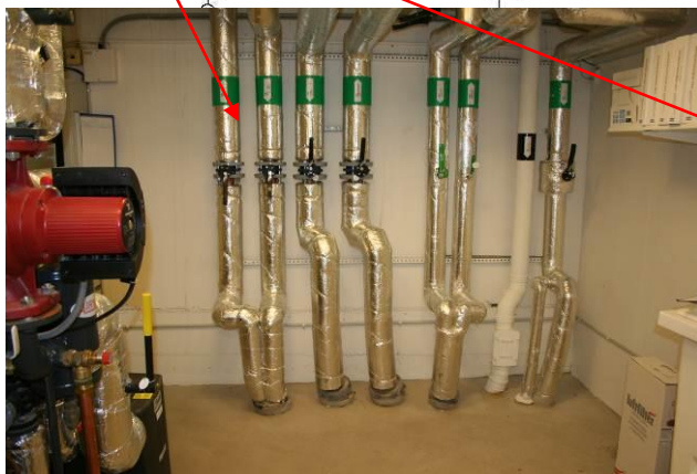
Bild 16. Från fjärrvärmeundercentral går värmeulvert med VS, VV och VVC till de 10 olika trapphusen.
