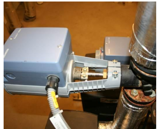
Bild 17. Styrventil VS02-SV21 förefaller alltför stor och arbetar i nästan stängt läge (mellan 0 till 1%) av öppet läge vid utetemperaturer kring och över 0°C.
