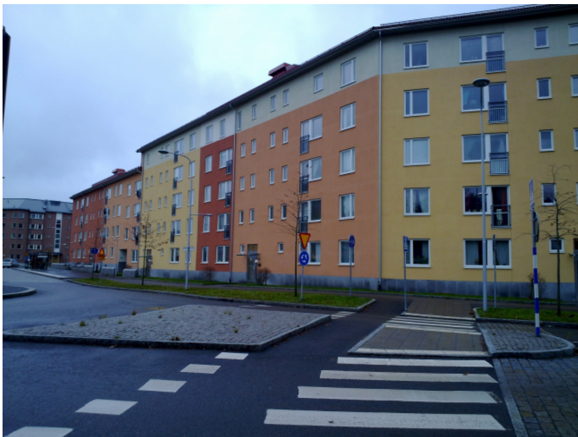
Tävlingshusets sydostliga fasad, sedd från Lännavägen.
