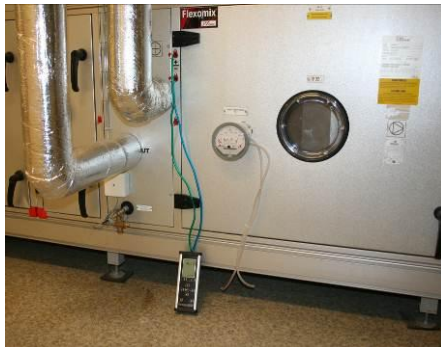
Bild 9. Mätning av tryckdifferens över inloppsdysa på TA2. Luftflödet har sedan tagits från tryck/flödesdiagram på aggregat.
