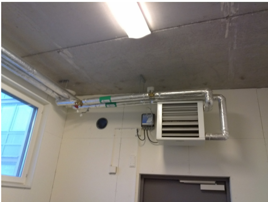
Värmeförstärkning i soprum pga oisolerat bjälklag.
