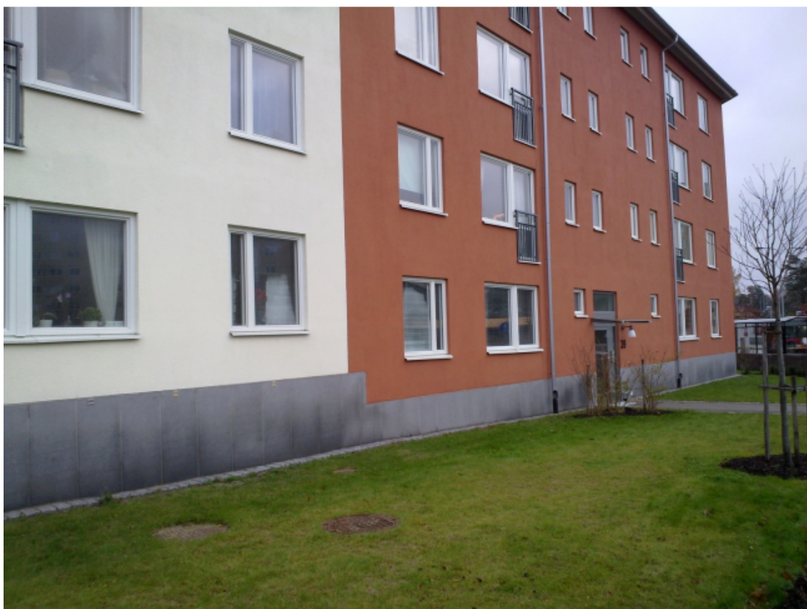
Tävlingshusets fasad mot Kommunalvägen i söder.
