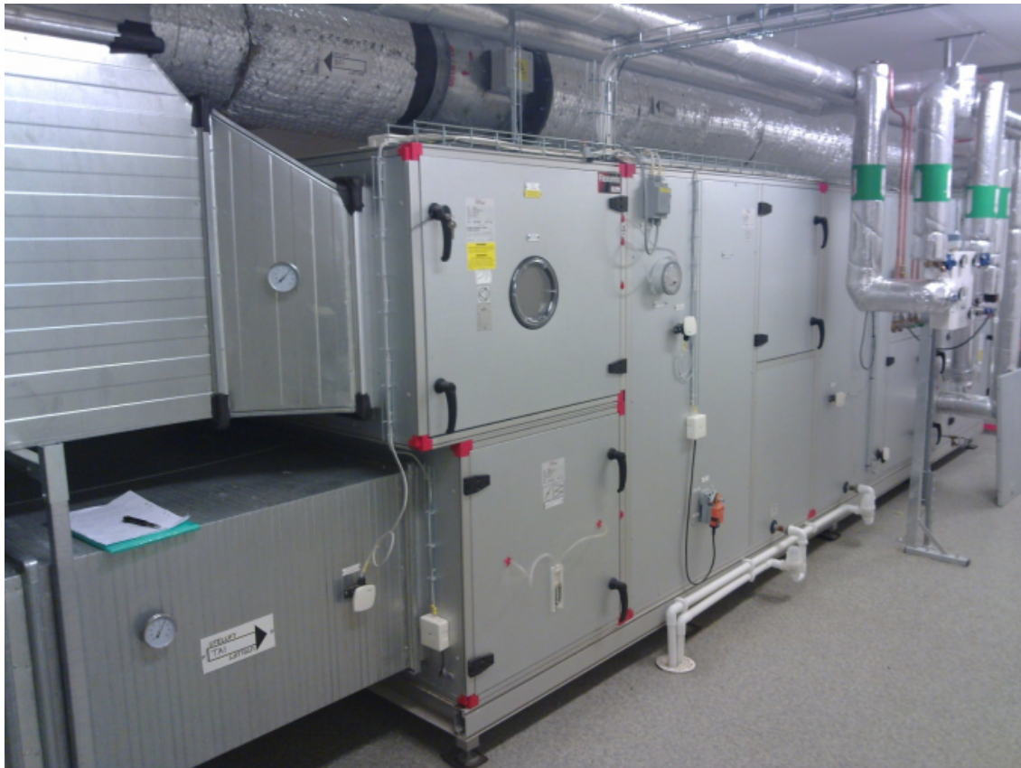
Ett av FTX-aggregaten med dubbla plattvärmväxlare.
