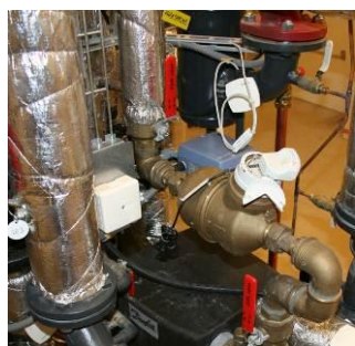
Bild 13. Varmvattenanvändningen mäts via separat flödesmätare.
