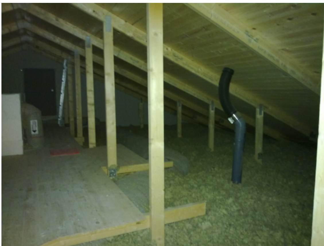
Vindsisolering med lösull och nätsolerade kanaler.
