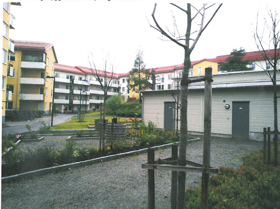
Bild 2. Tävlingsbyggnaden sett från gårdssidan.
