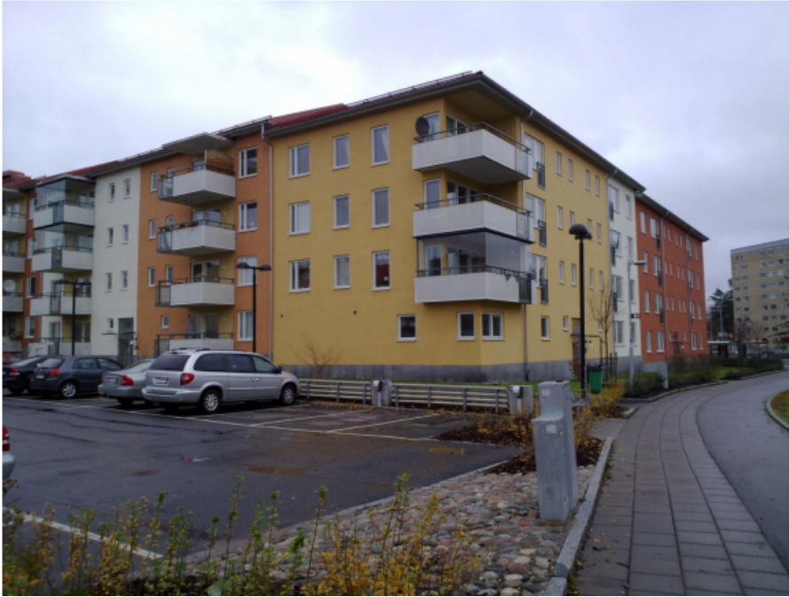
Figur 2. Tävlingsbyggnaden, Huga Fastigheters flerbostadshus på Kansliet 1 i Huddinge. Foto: Per Levin.
