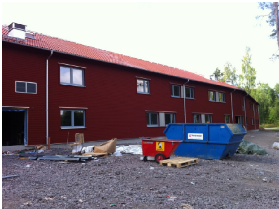
Figur 1. Byggproduktion vid elevhemmet i Kvarn 2011. Foto: Per Wickman, Aton Teknikkonsult AB.
